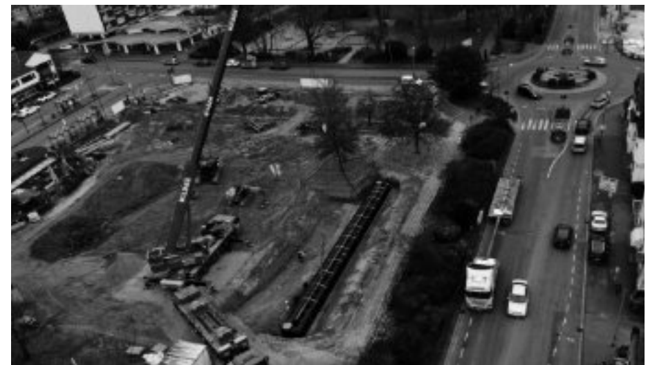
65.000 Liter Wasser fasst der Regenspeicher, der 2022 im Alten Stadtpark eingelassen wurde (oben).
