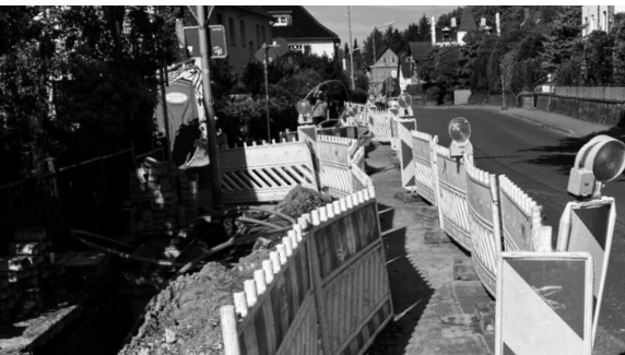
Glasfaser-Tiefbauarbeiten im April in der Immigrather Straße
