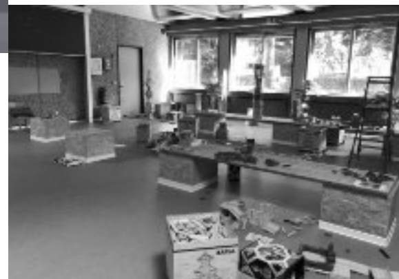
Nach der Flut 2021 mussten auch die Räumlichkeiten der OGS der Grundschule Büscherhof im ehemaligen Hauptschulgebäude saniert werden. Dies ist abgeschlossen. Bild: Stadt Leichlingen
