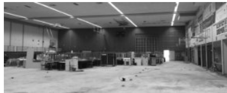
Während in der Großsporthalle am Hammer die Sanierung nun endlich beginnen kann (oben), ist die Sporthalle an der Sekundarschule im November endlich nach der Sanierung freigegeben worden (unten). Beide Hallen hatte die Flut beim Starkregen im Juli 2021 ereilt. Bilder: Stadt Leichlingen
