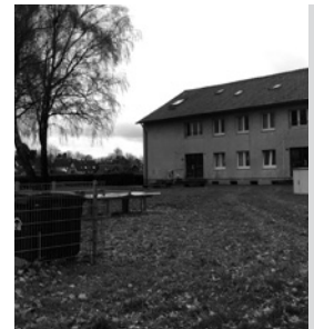
(Abb. 4) Weder der bauliche Zustand, noch der Standort ist aus Sicht der SPD-Fraktion tragbar: Flüchtlingsunterkunft in Oberschmitte
