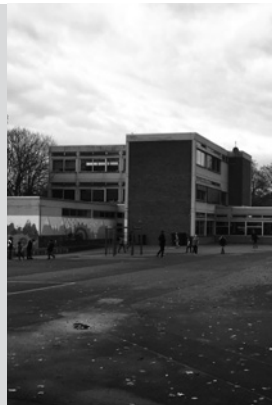
(Abb. 20) Haben eine Sanierung nötig: Die Gebäude der Grundschule Büscherhof
